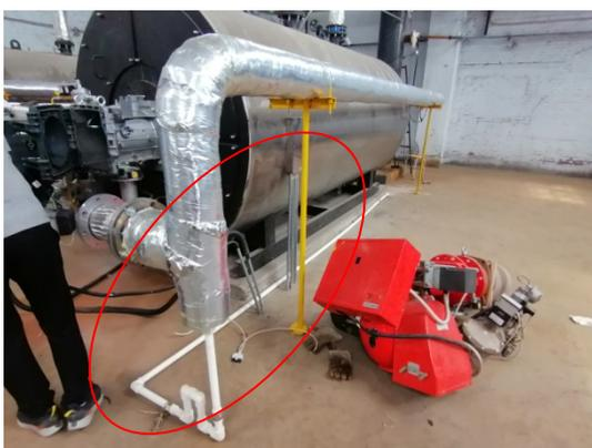
图 4-7 冷凝水排放管道
