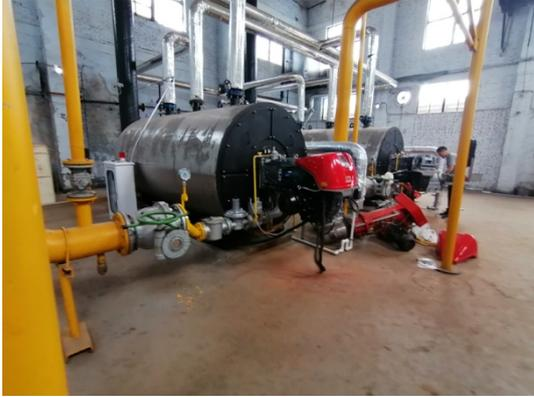
图 4-9 改造后燃气锅炉
