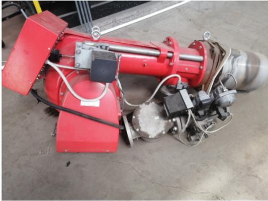
图 4-3 拆除的锅炉燃烧器
