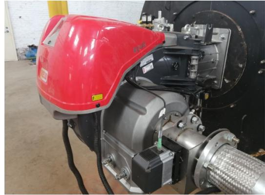
图 4-4 改造后低氮燃烧器
