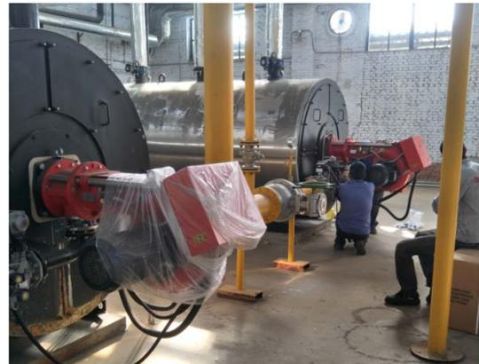
图 4-2 原有燃气锅炉及燃烧器
